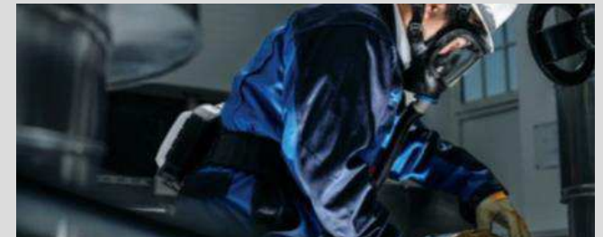
Baugewerbe, Renovierung, Abriss
